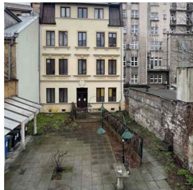
Podwórze kongregacyjne przy ul. Garbarskiej 14 niebawem wypięknieje, zostaną tam nasadzone rośliny
